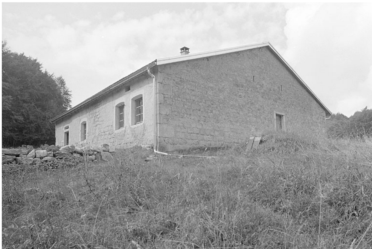
Façade antérieure et face nord-est.
