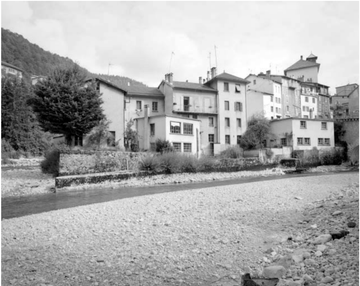
Bâtiments vus du sud.
