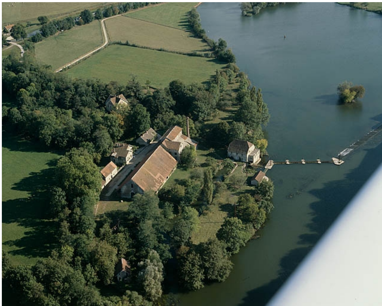
Vue aérienne plongeante depuis le nord en 1989.
