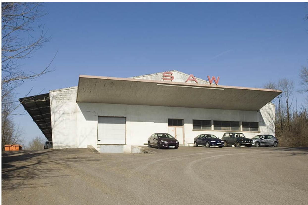
Mur-pignon de l'atelier de fabrication (rondelles).
