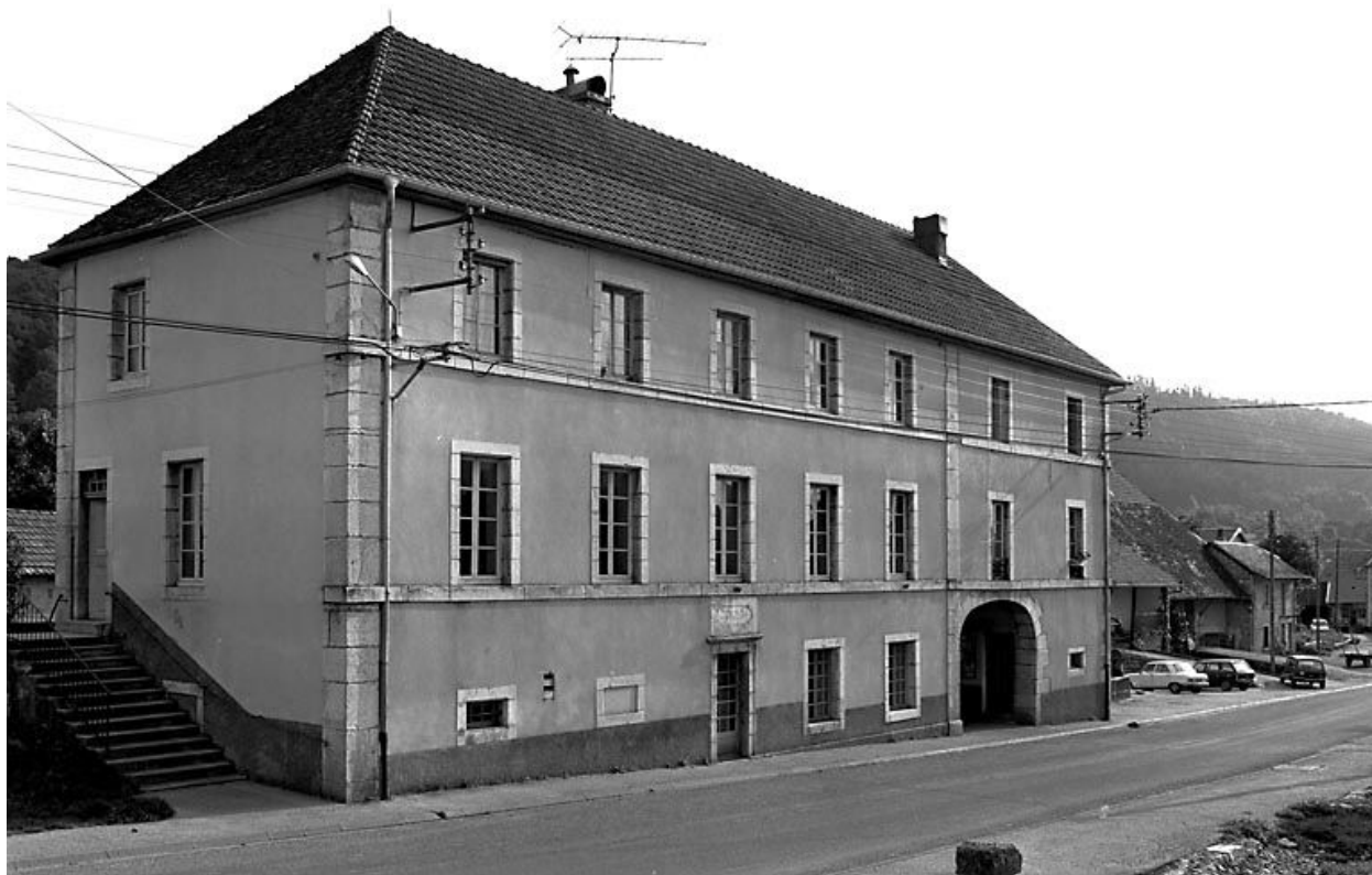
Mairie-école située Grande Rue.
