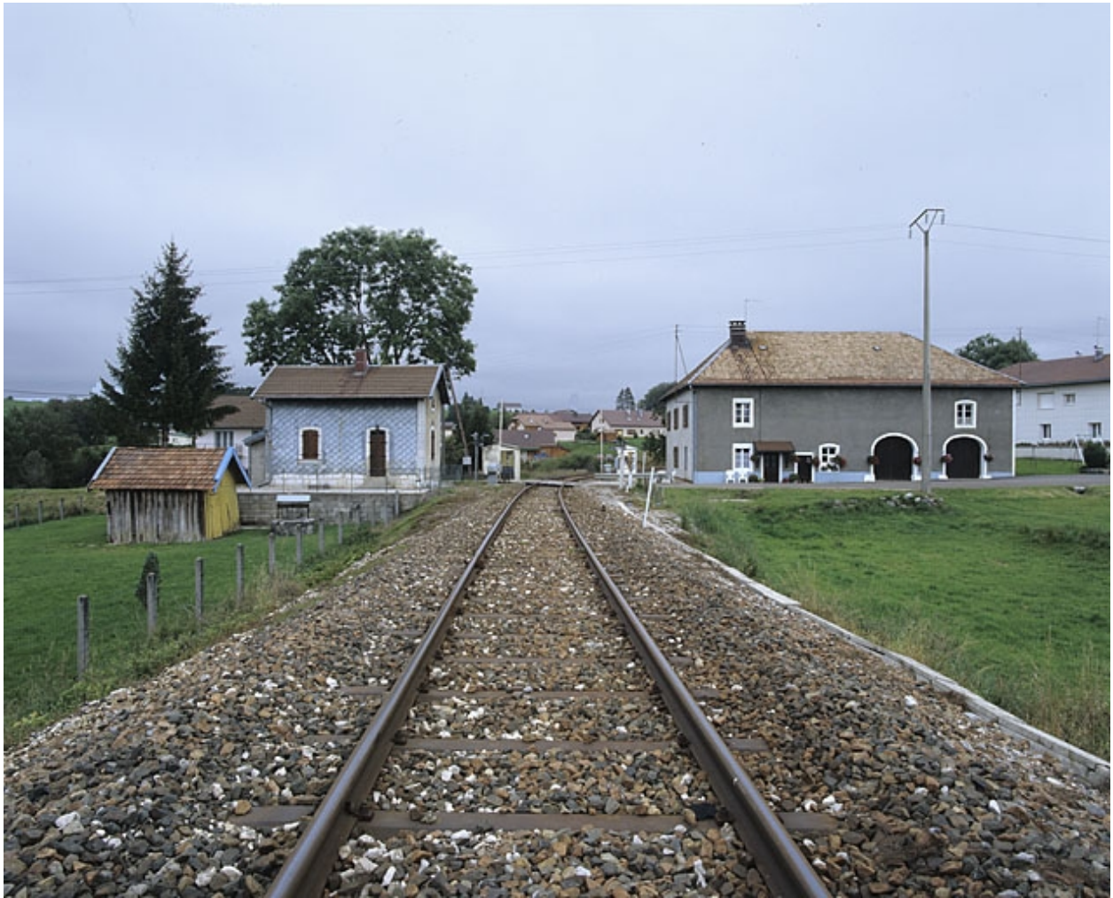
Vue d'ensemble depuis la voie, au sud.
