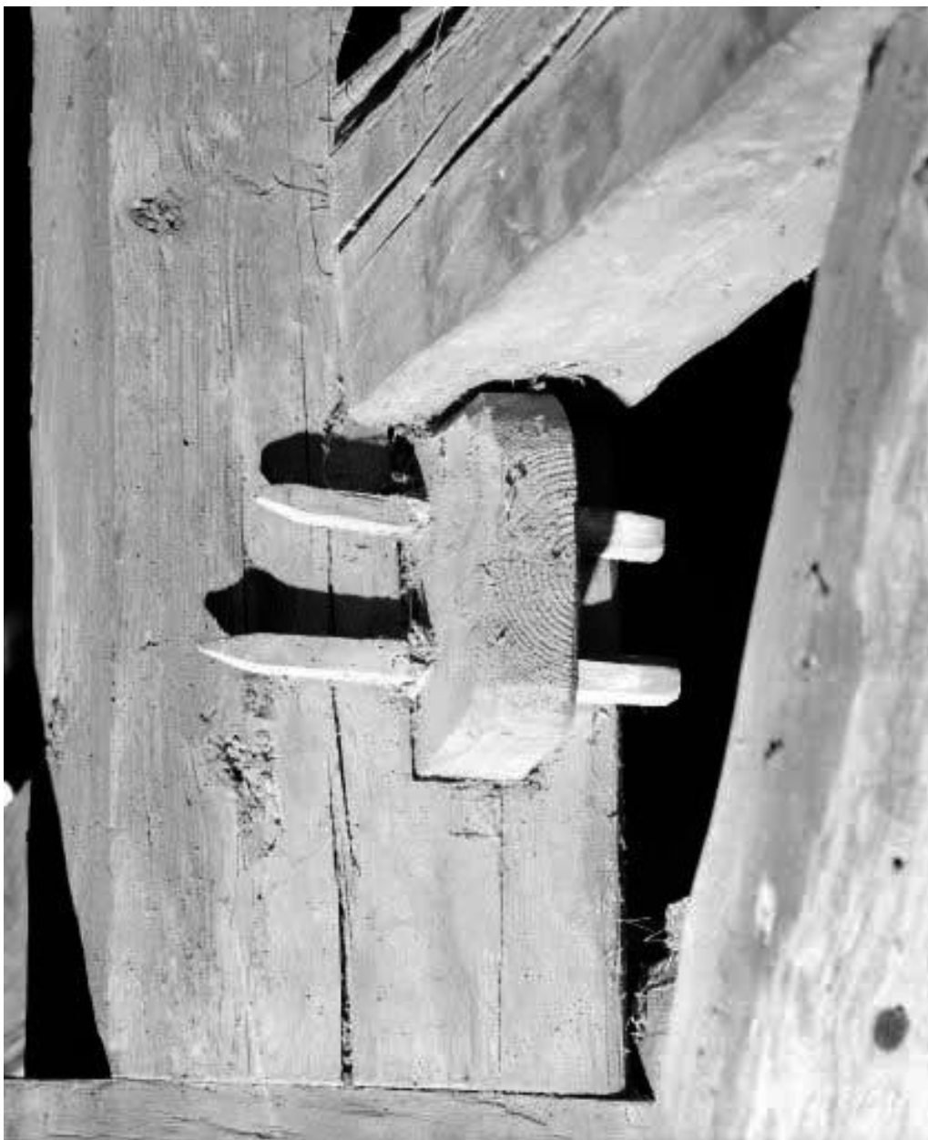
Détail : assemblage de charpente.
