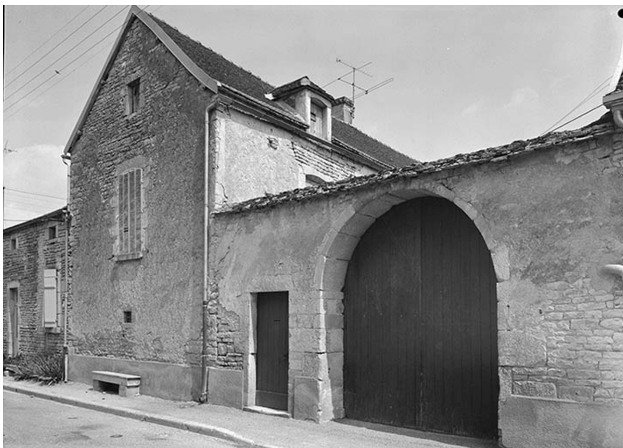
Mur-pignon et portail sur rue.
