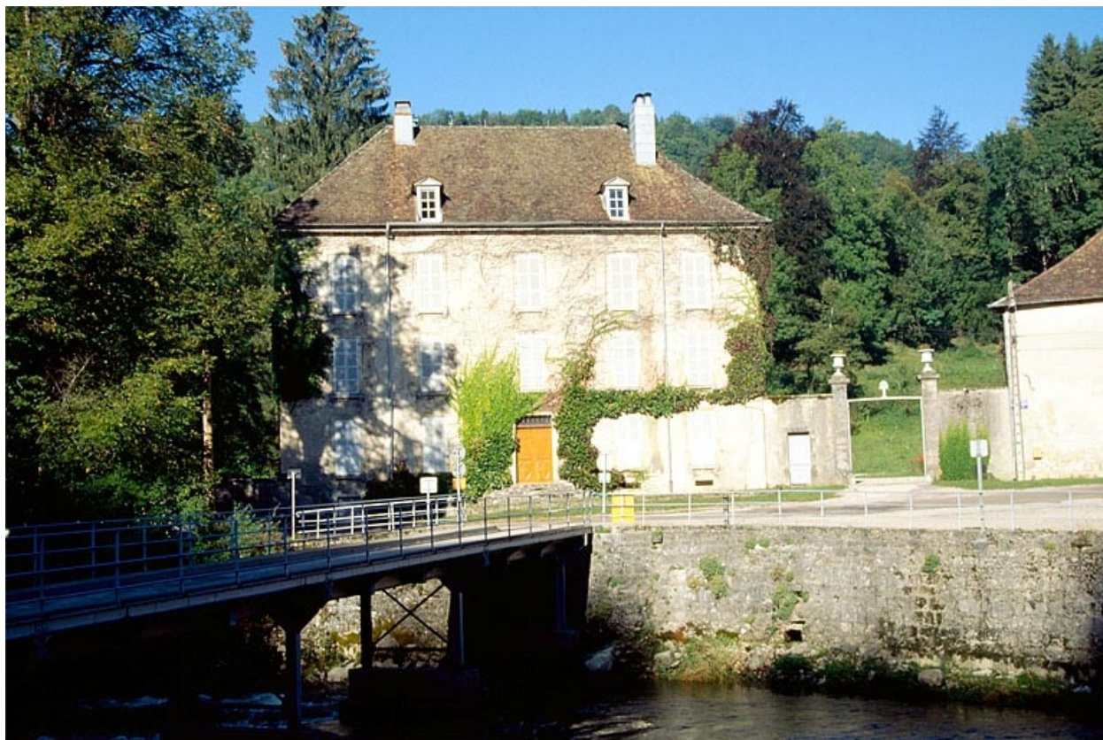
Façade antérieure du logement patronal.
