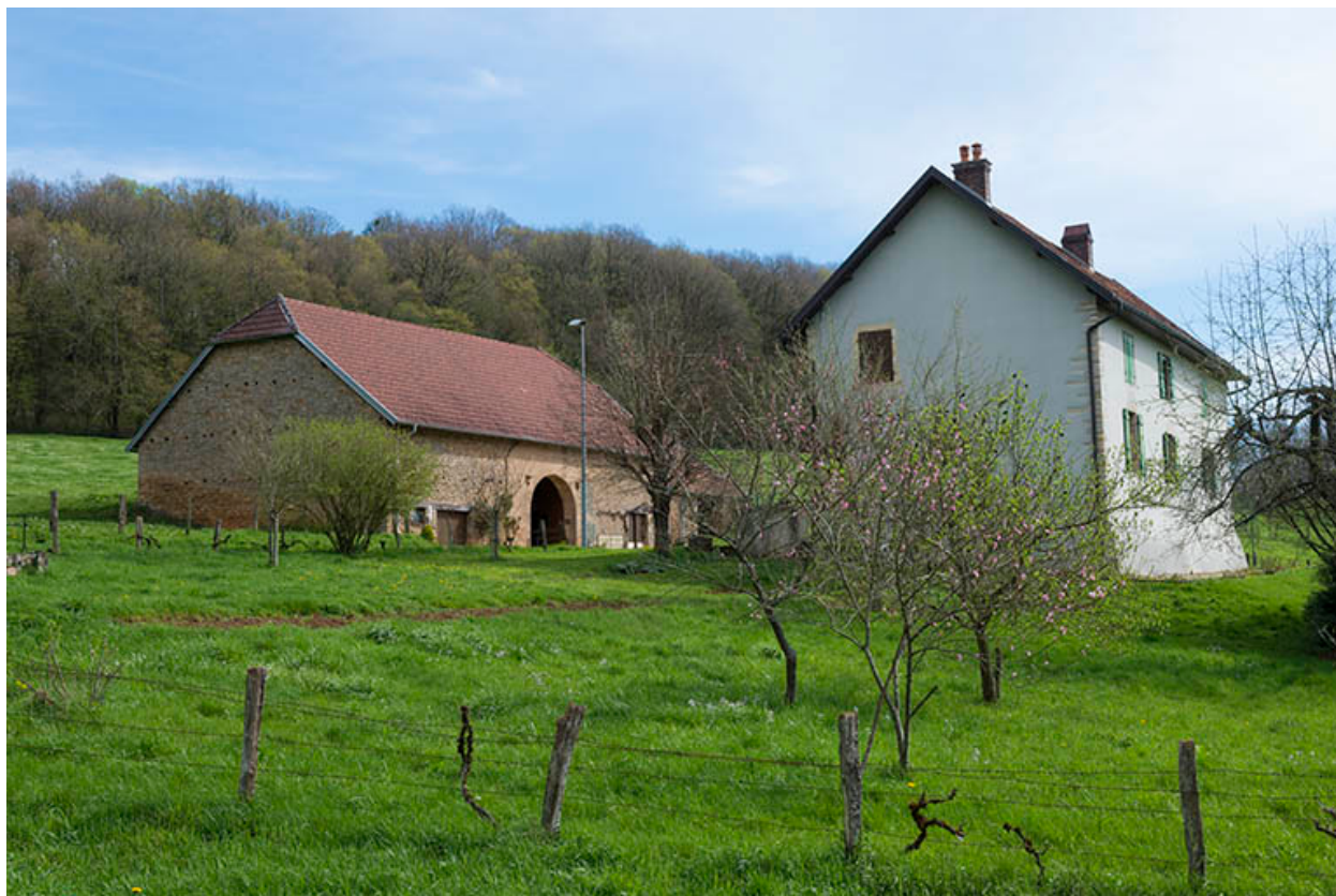
Vue depuis l'ouest.
