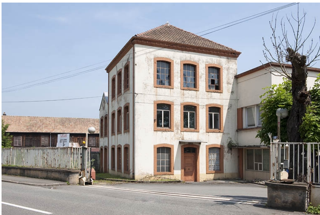
Bâtiment d'entrée vu de trois quarts.
