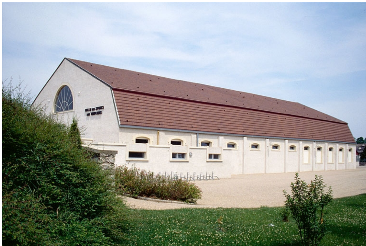
Façade latérale gauche du gymnase.
