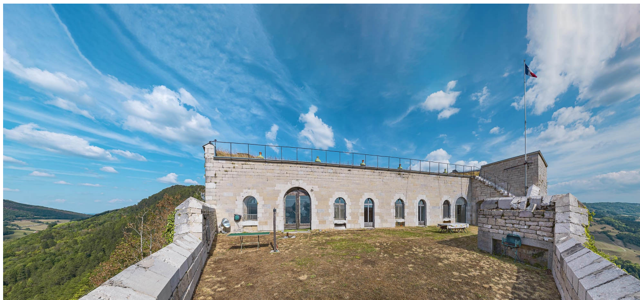
Vue depuis l'échauguette de la façade postérieure.
