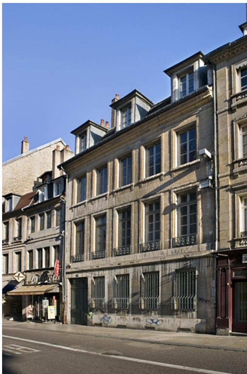
Vue d'ensemble du logis principal sur rue.
