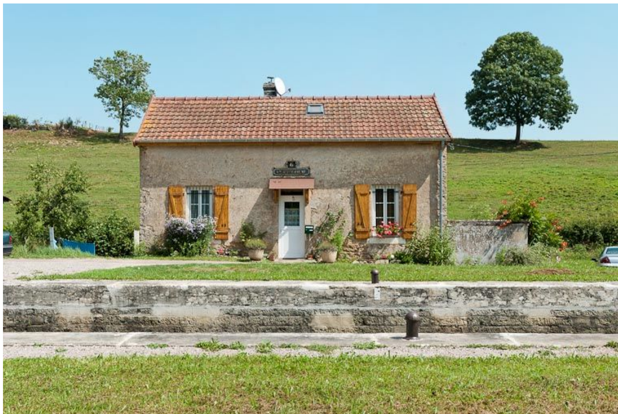
Vue de face de la maison éclusière.
