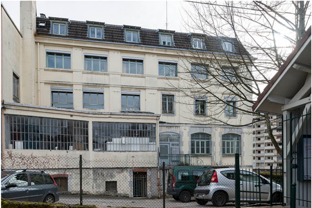
Façade nord de l'atelier principal.
