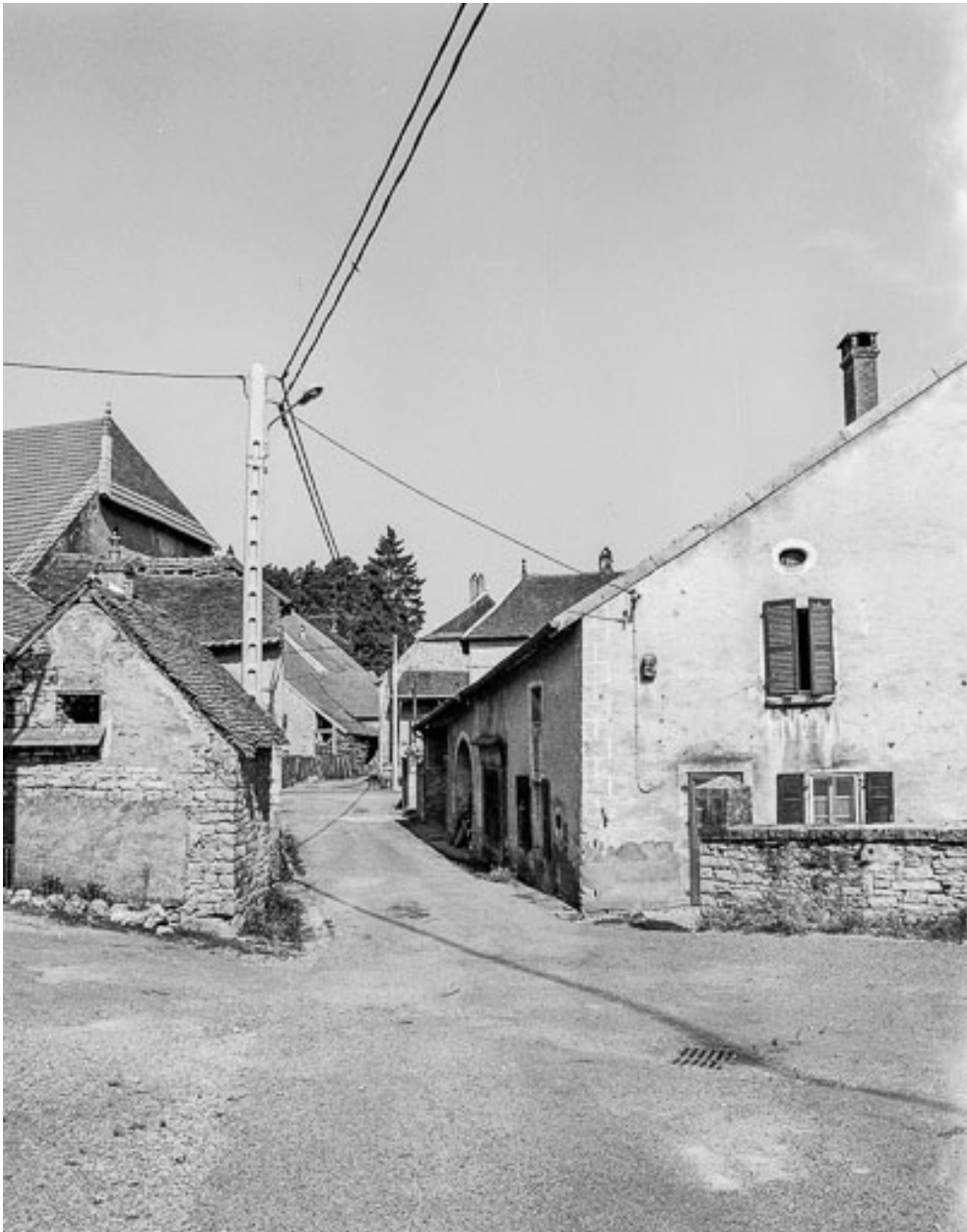
Maison située entre la rue de la Traverse et la ruelle des Escaliers : façades antérieure et latérale gauche.
