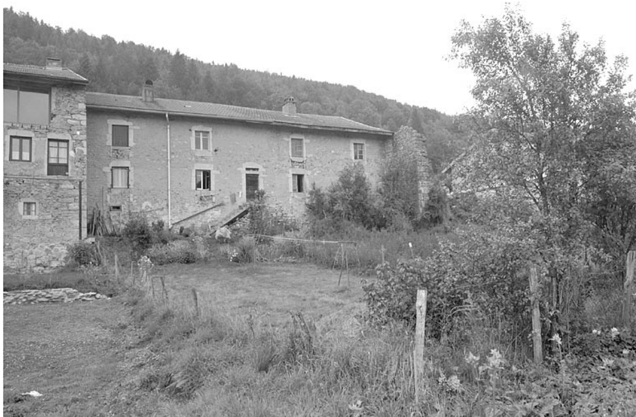
Façade postérieure, vue générale.
