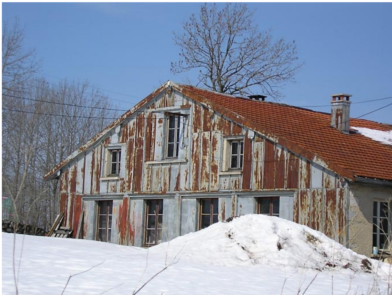
Vue du pignon sud-ouest.
