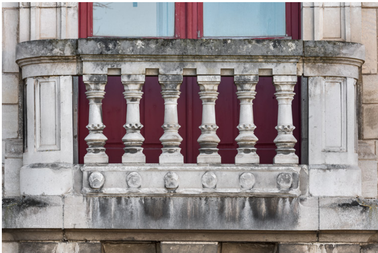
Façade latérale gauche : garde-corps du balcon.
