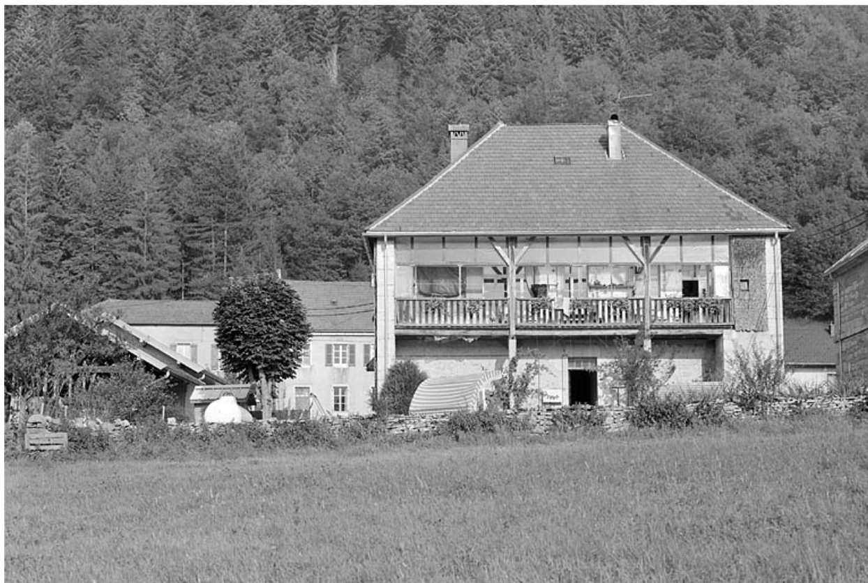
Vue générale de la façade postérieure.
