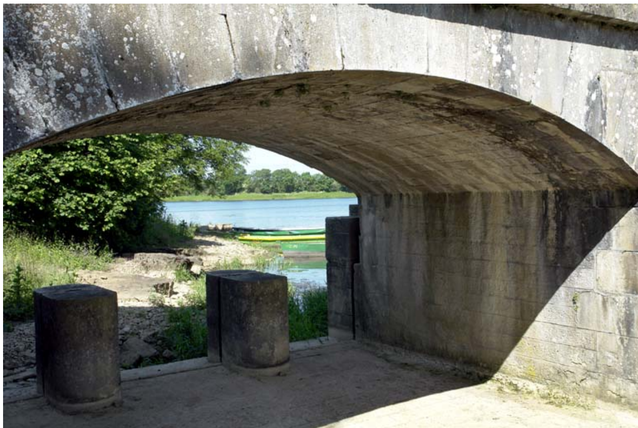
Déversoir de superficie.
