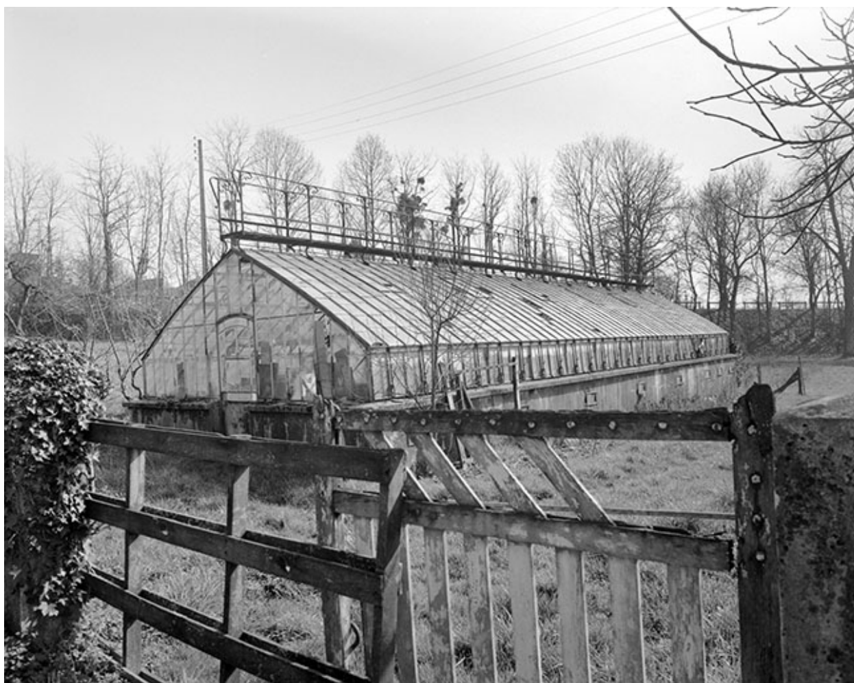
Vue d'ensemble de la serre.
