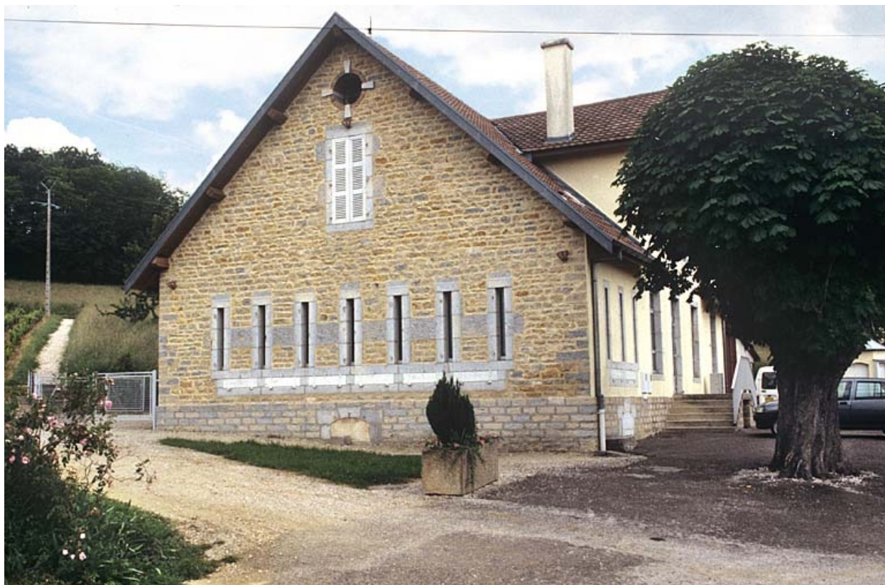
Façade latérale gauche (chambre à lait).
