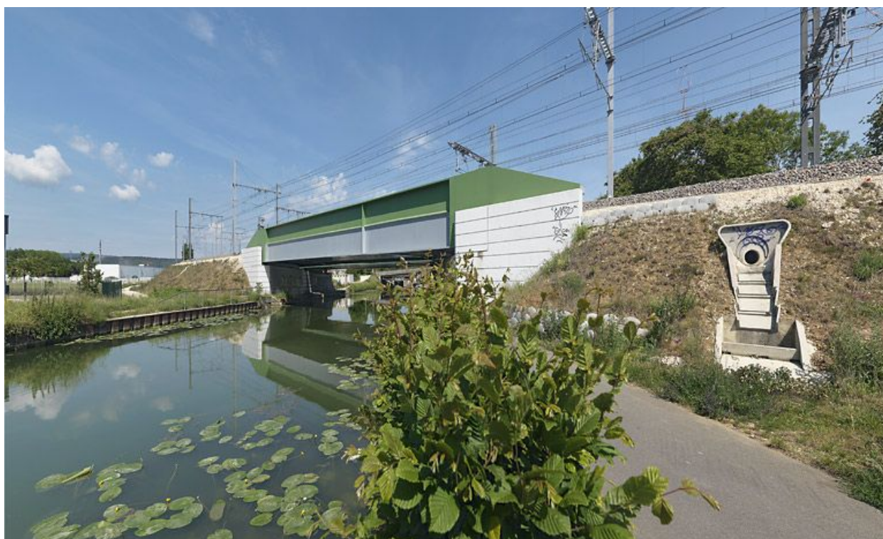
Vue d'ensemble d'aval.
