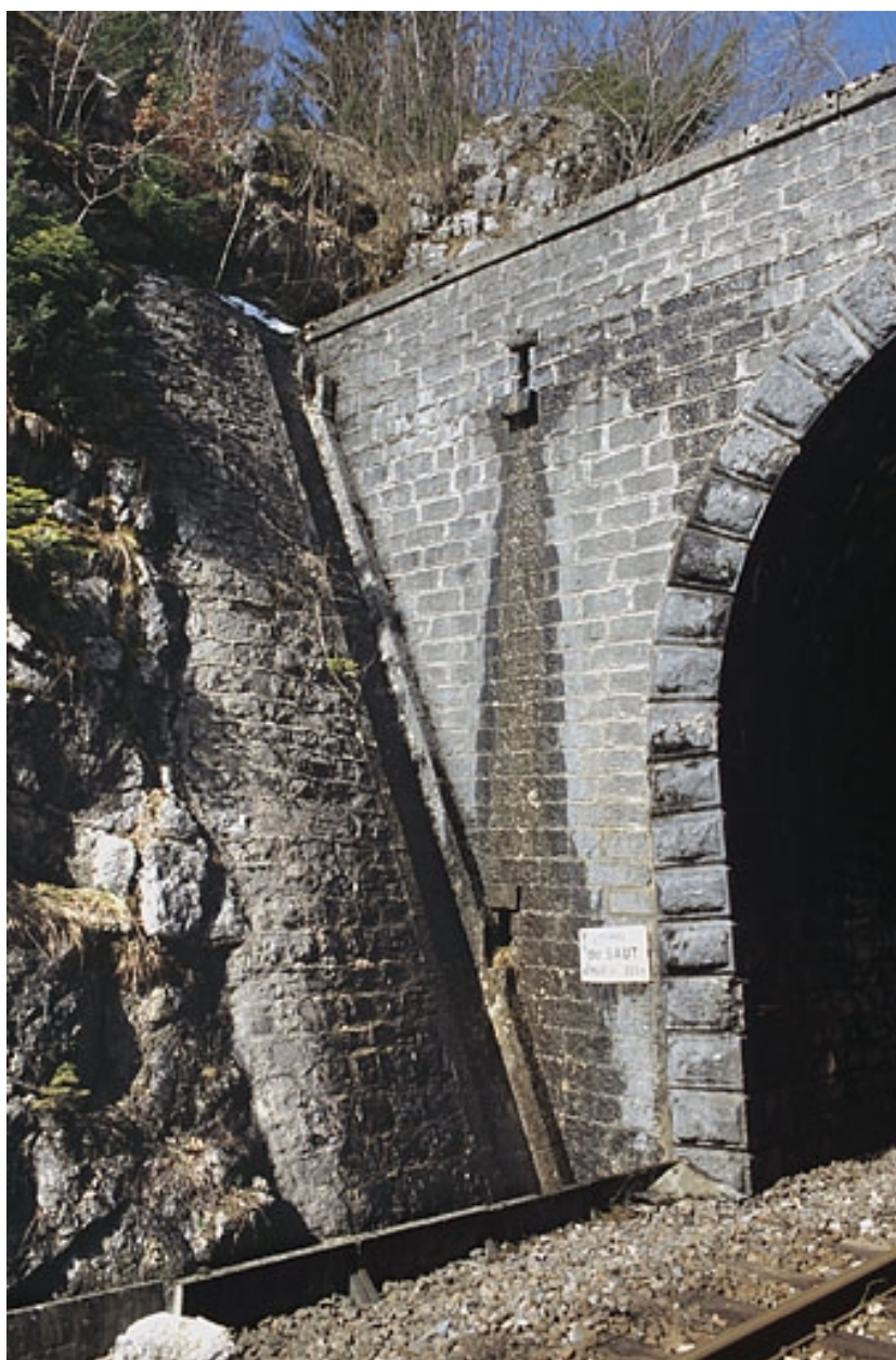
Tête côté La Cluse : descente d'eau, chantepieures et caniveau.
