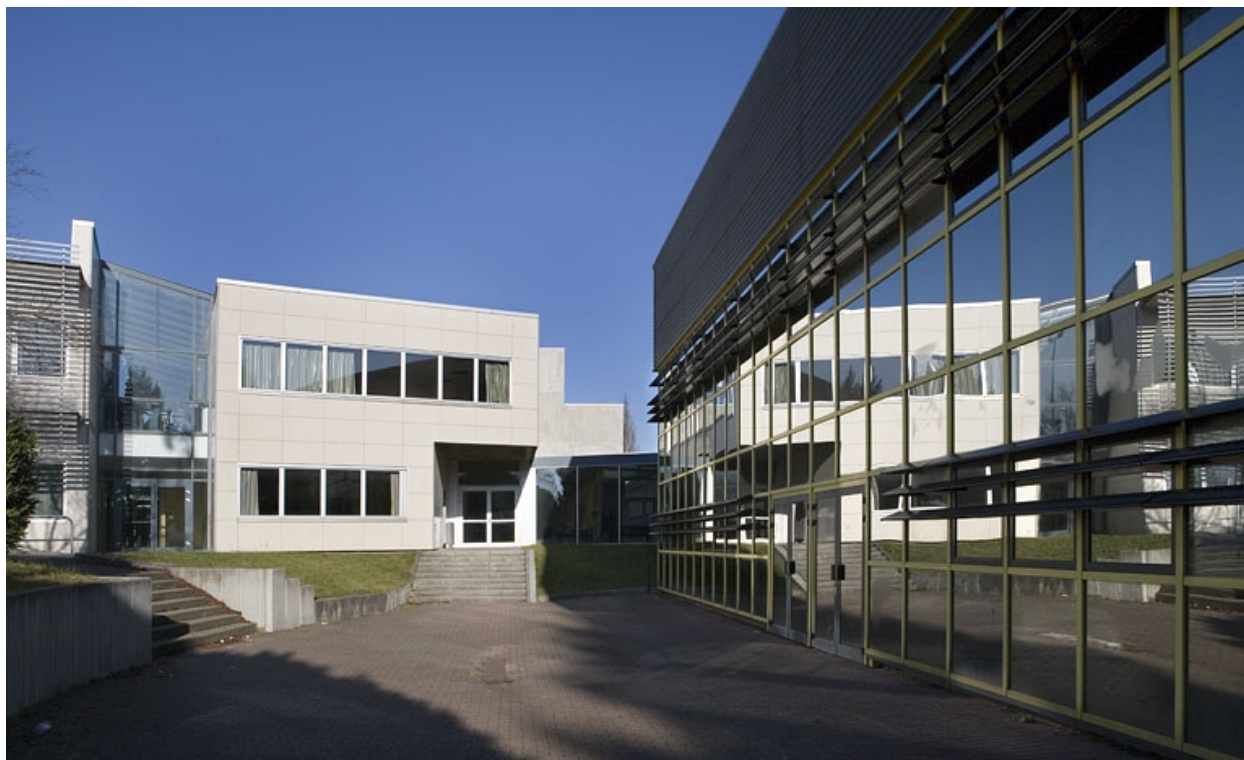
Vue de la façade antérieure bâtiment B.
