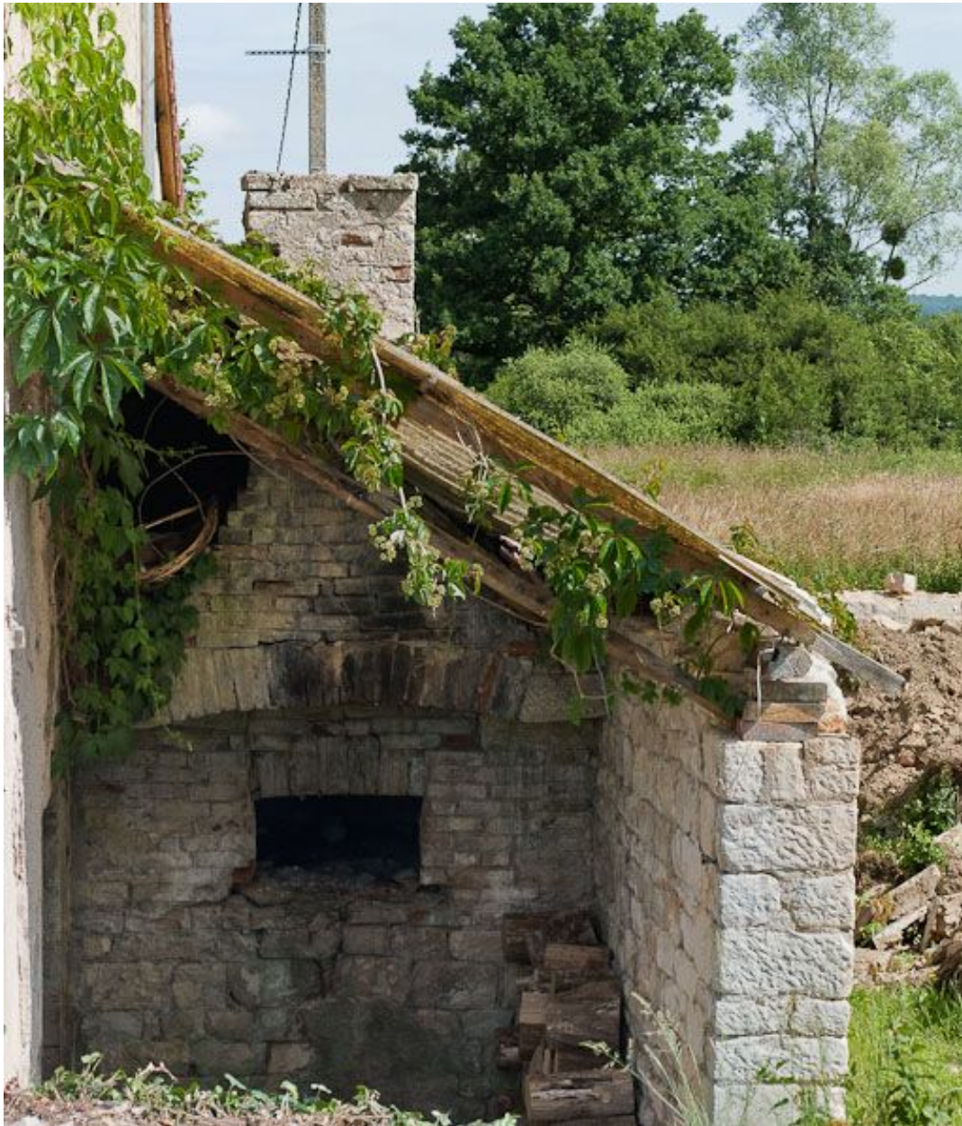
Vue du four à pain.
