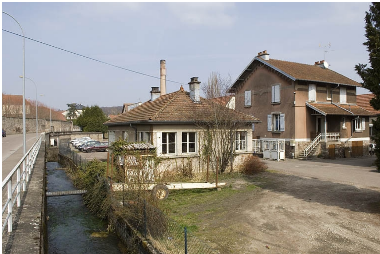
Conciergerie et logement ouvrier depuis le sud-ouest.
