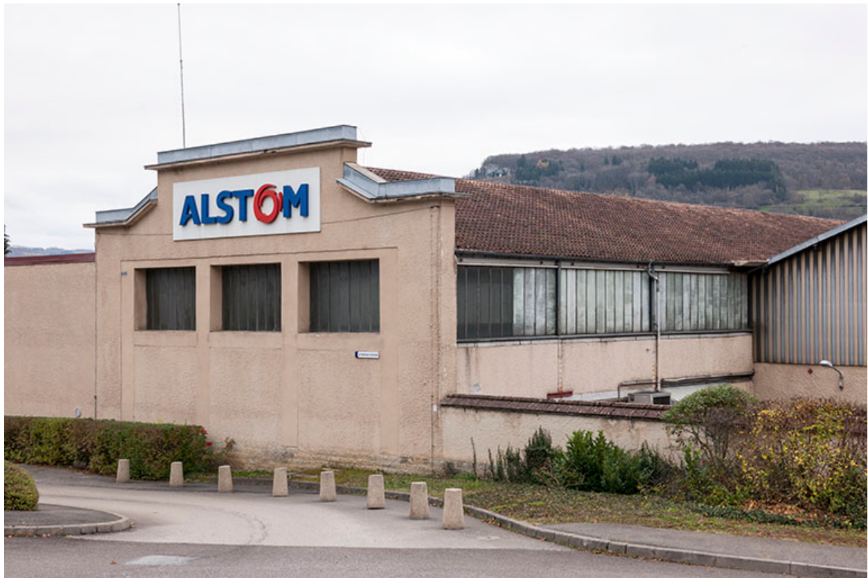
Mur-pignon de l'ancienne hall ouest.
