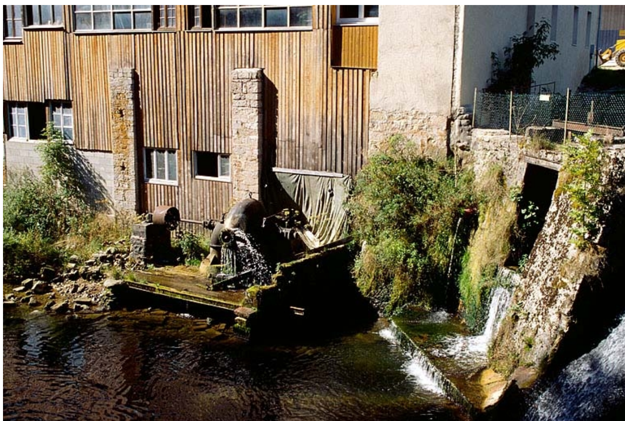
Moulin Choudet : la turbine et le barrage.
