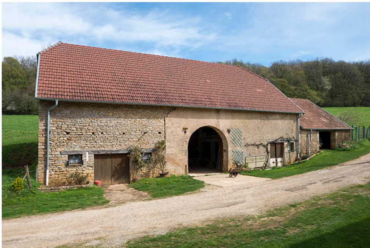
façade antérieure de la grange.
