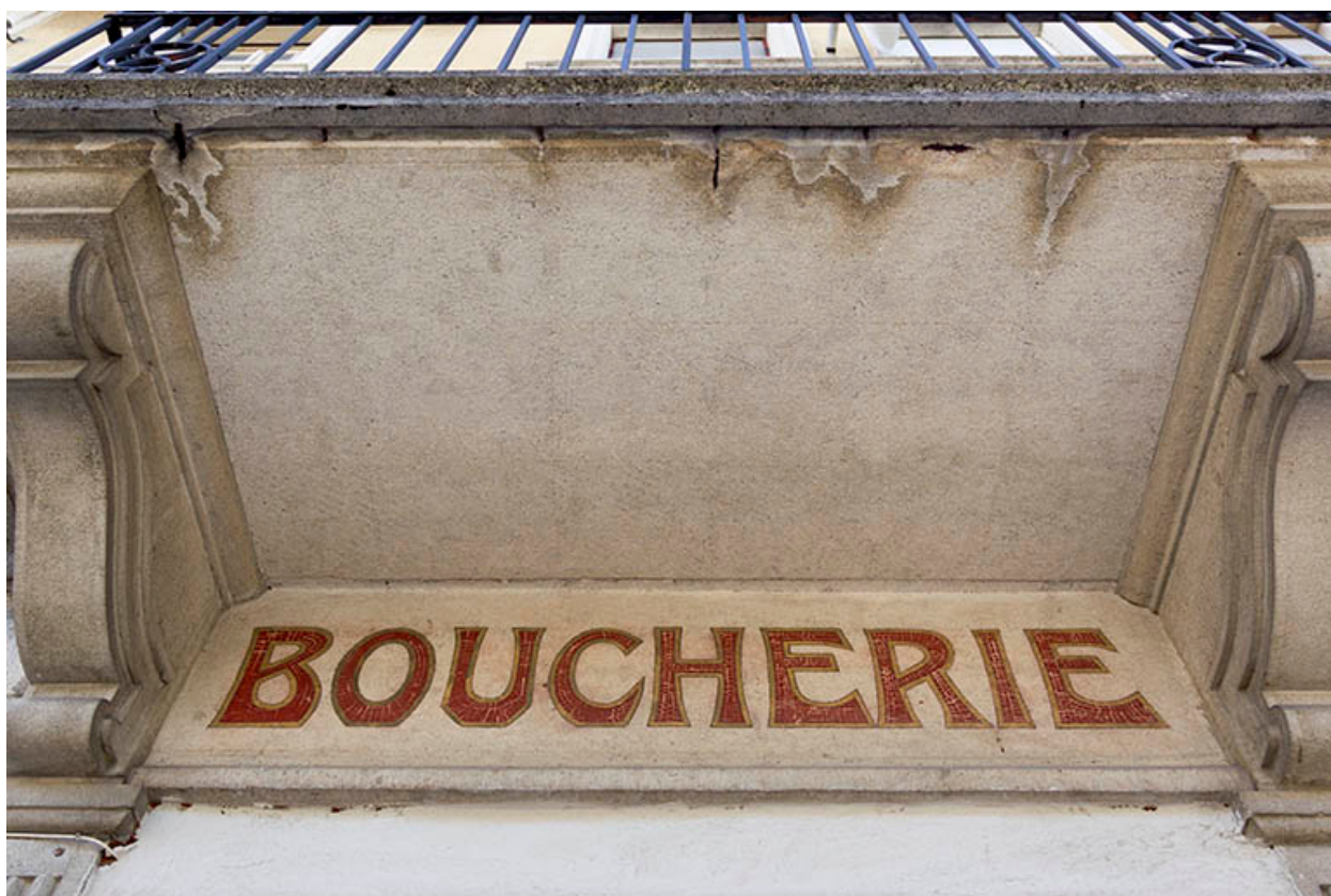
Façade antérieure : partie gauche de l'enseigne peinte.
