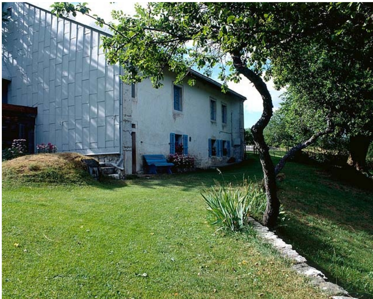
Ferme située au lieu-dit Sur les Couronnes.
