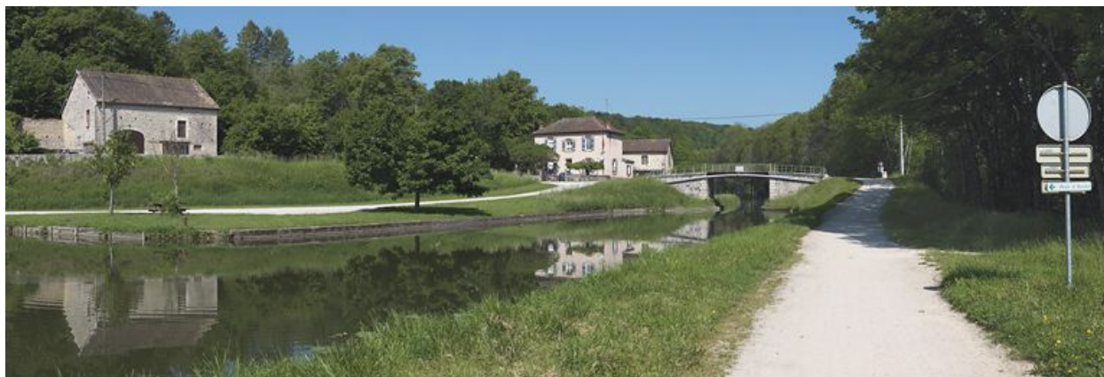
Le pont isolé de Crugey vu d'aval.
