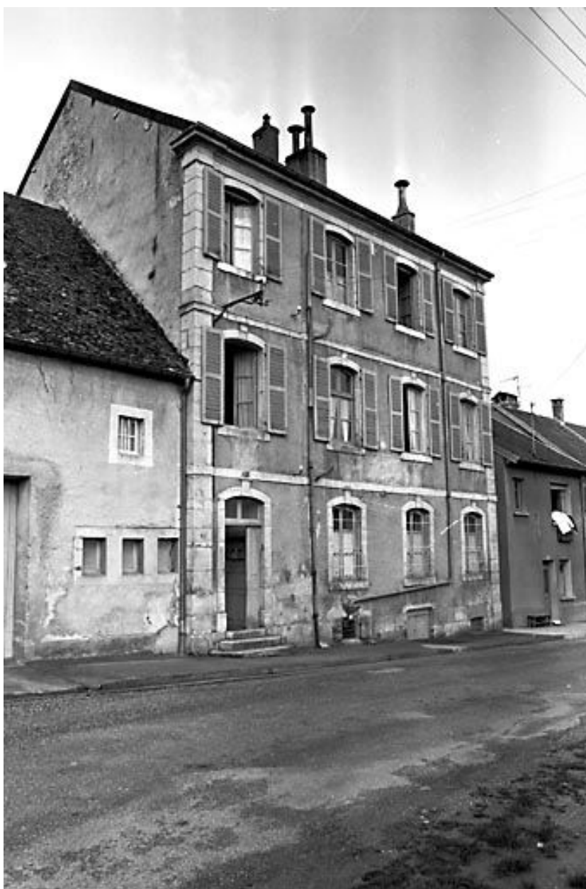
Maison située 28 rue du Seult.
