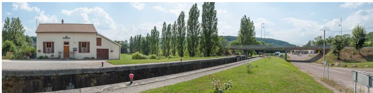
Vue d'ensemble du site d'écluse.
