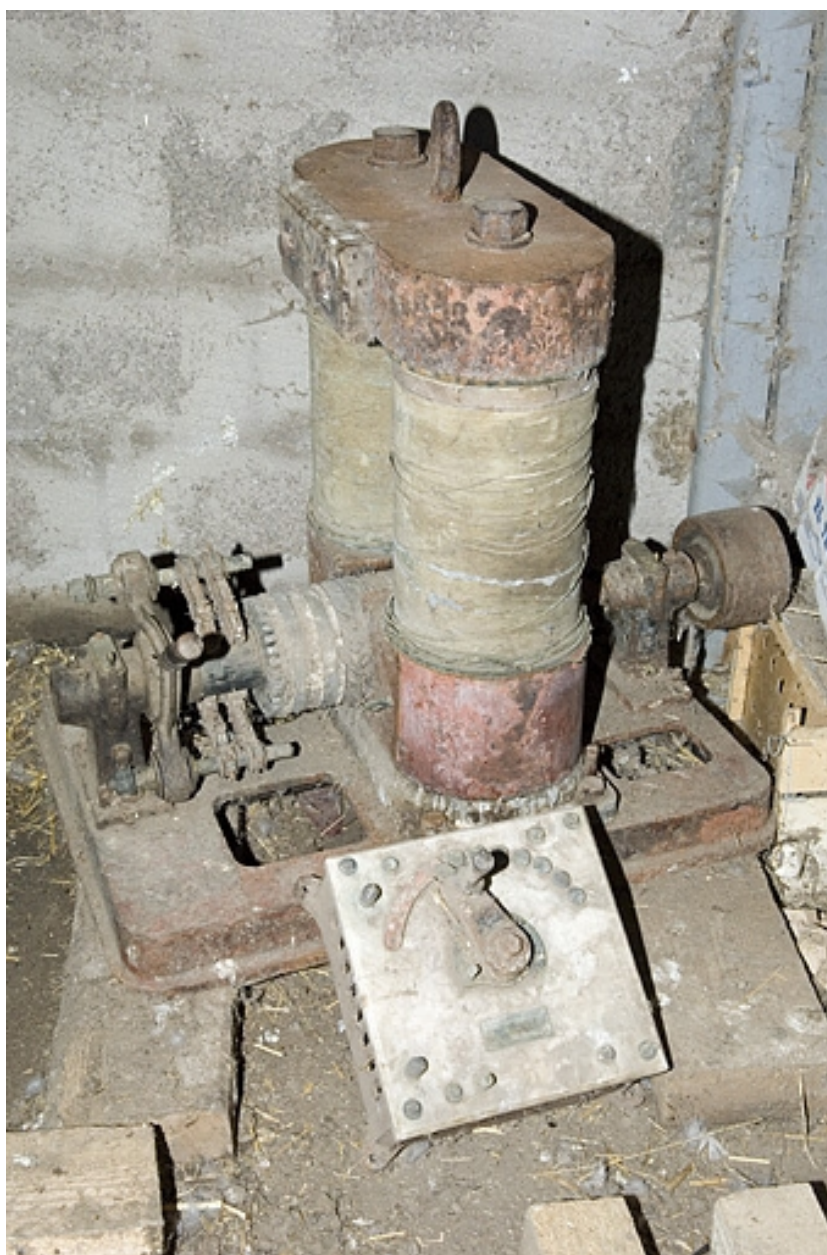
Moteur électrique Edison et tableau électrique.
