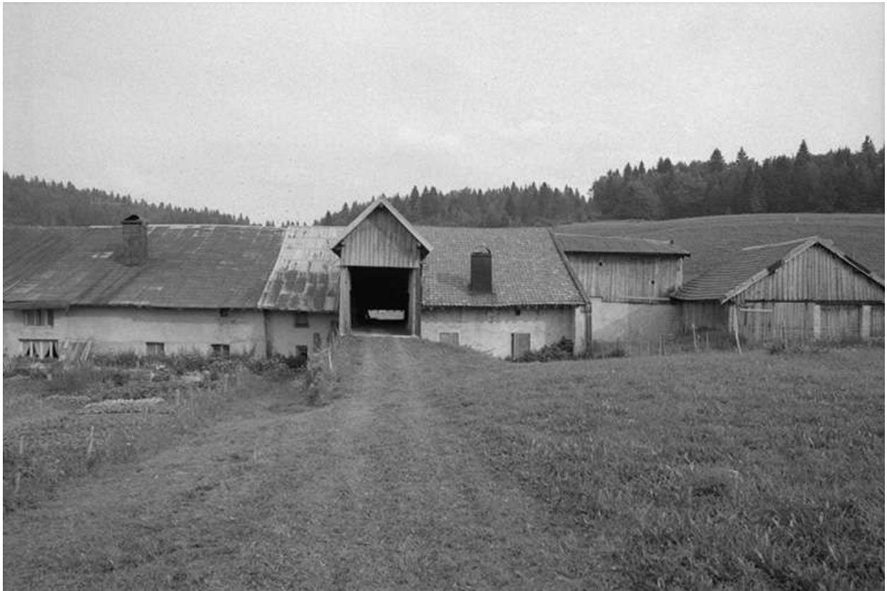
Façade postérieure avec pont de grange.
