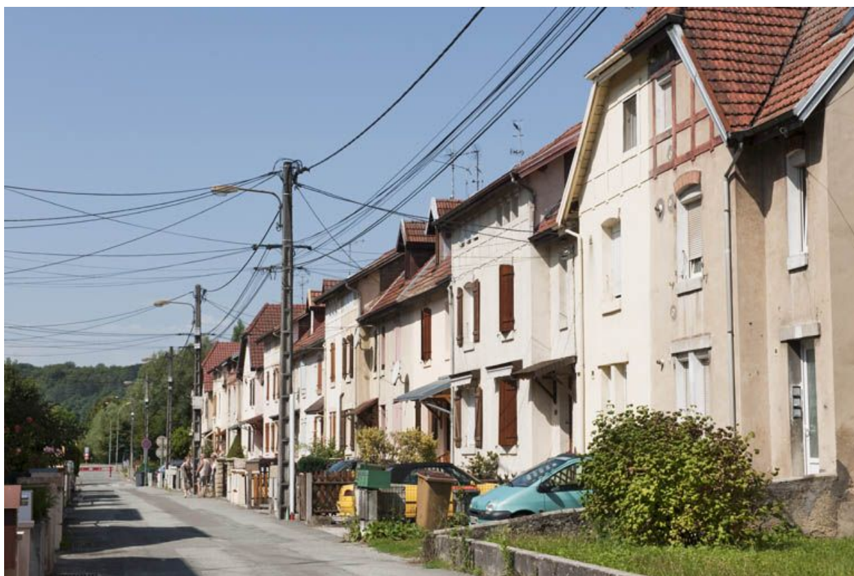
Rue de Somme. Façades sud.
