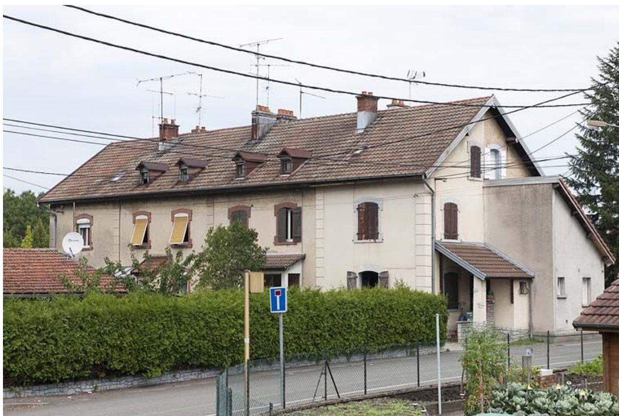
Habitation à 8 logements. Vue depuis le sud.
