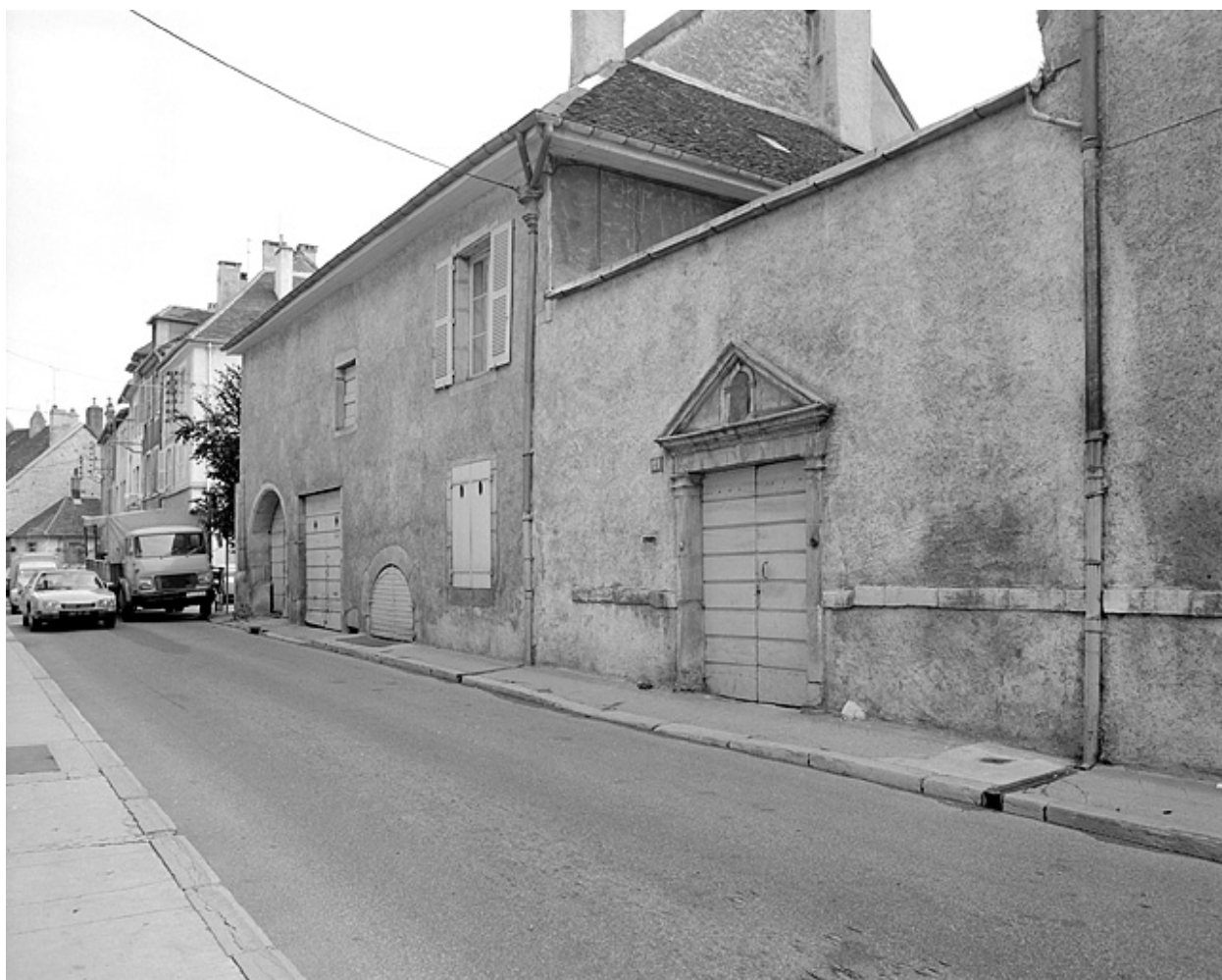
Façade antérieure, partie centrale.
