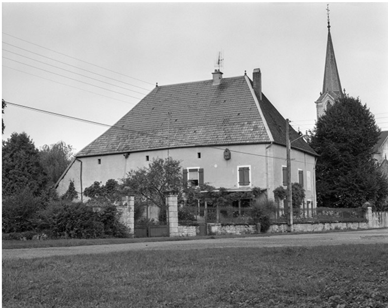
Ferme située route Vers le lavoir.
