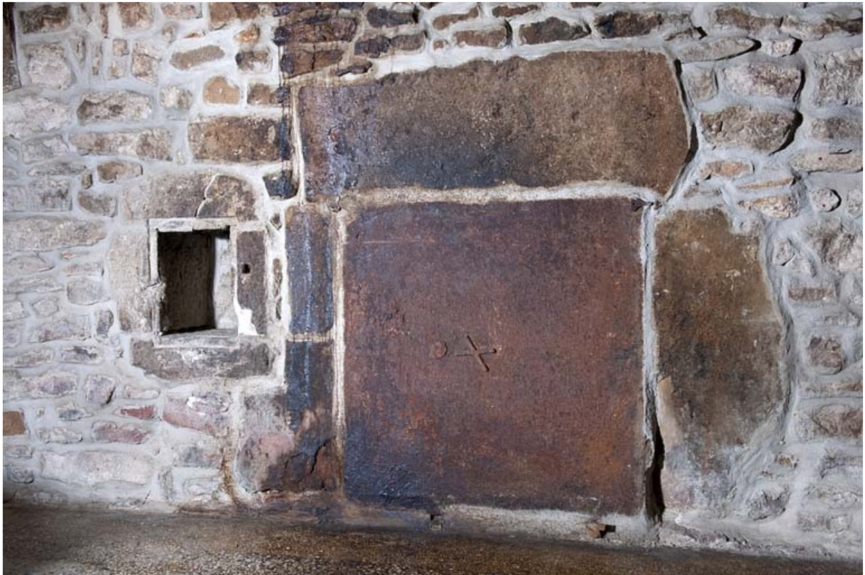
Intérieur : détail de la cheminée.
