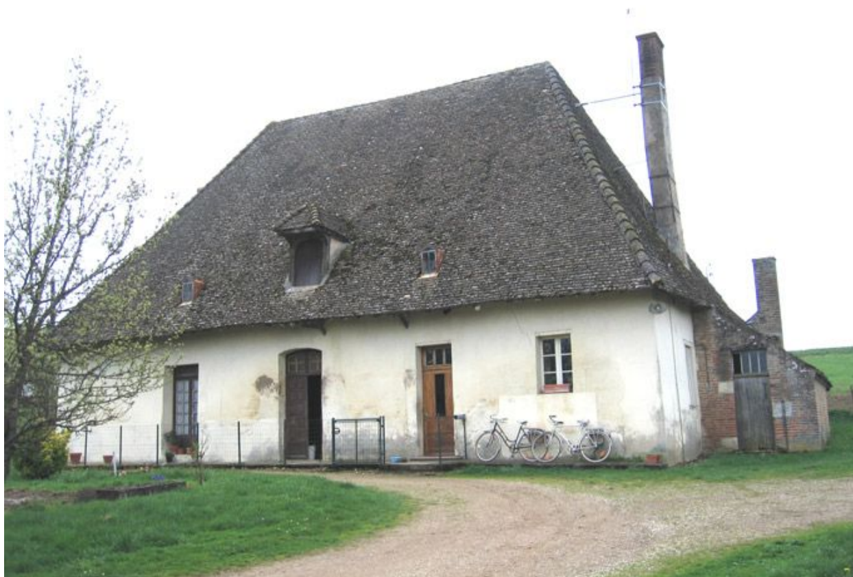
Vue d'ensemble de la façade.
