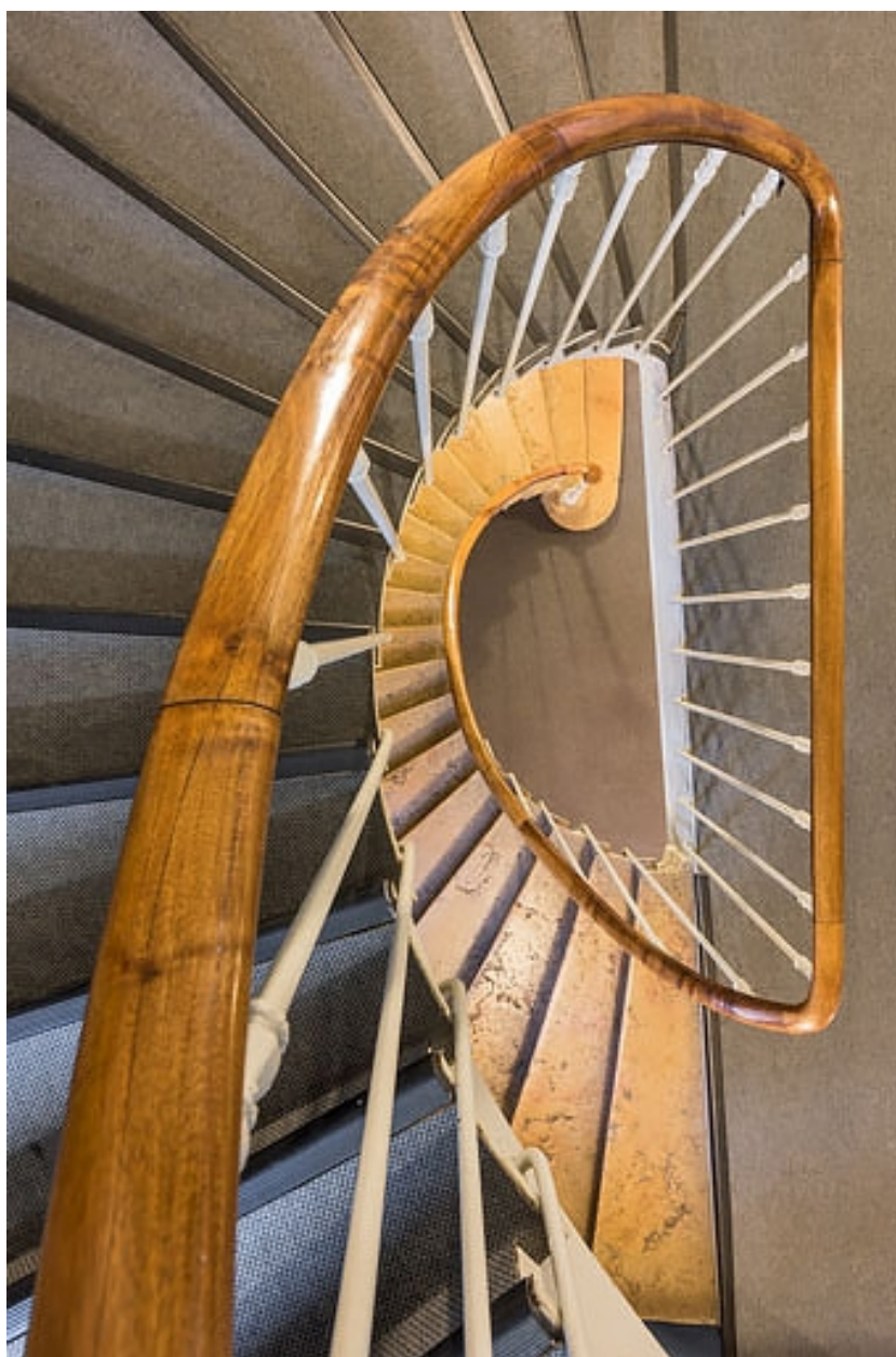
Escalier côté cour : rampe vue du dessus.
