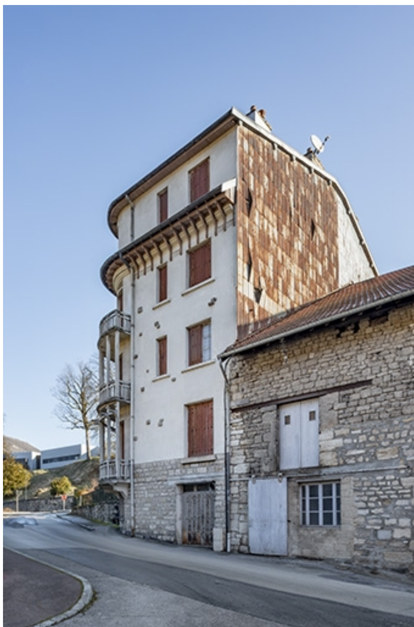
Vue depuis le sud-ouest.
