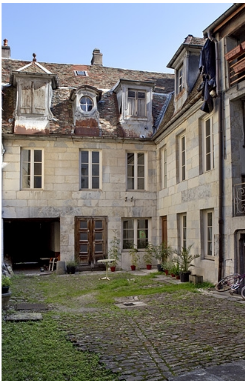
Façade antérieure du premier logis secondaire.
