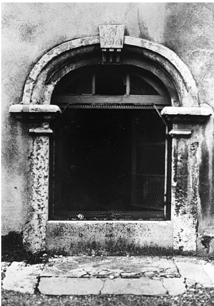
Baie sur la façade sud (état en 1978).
