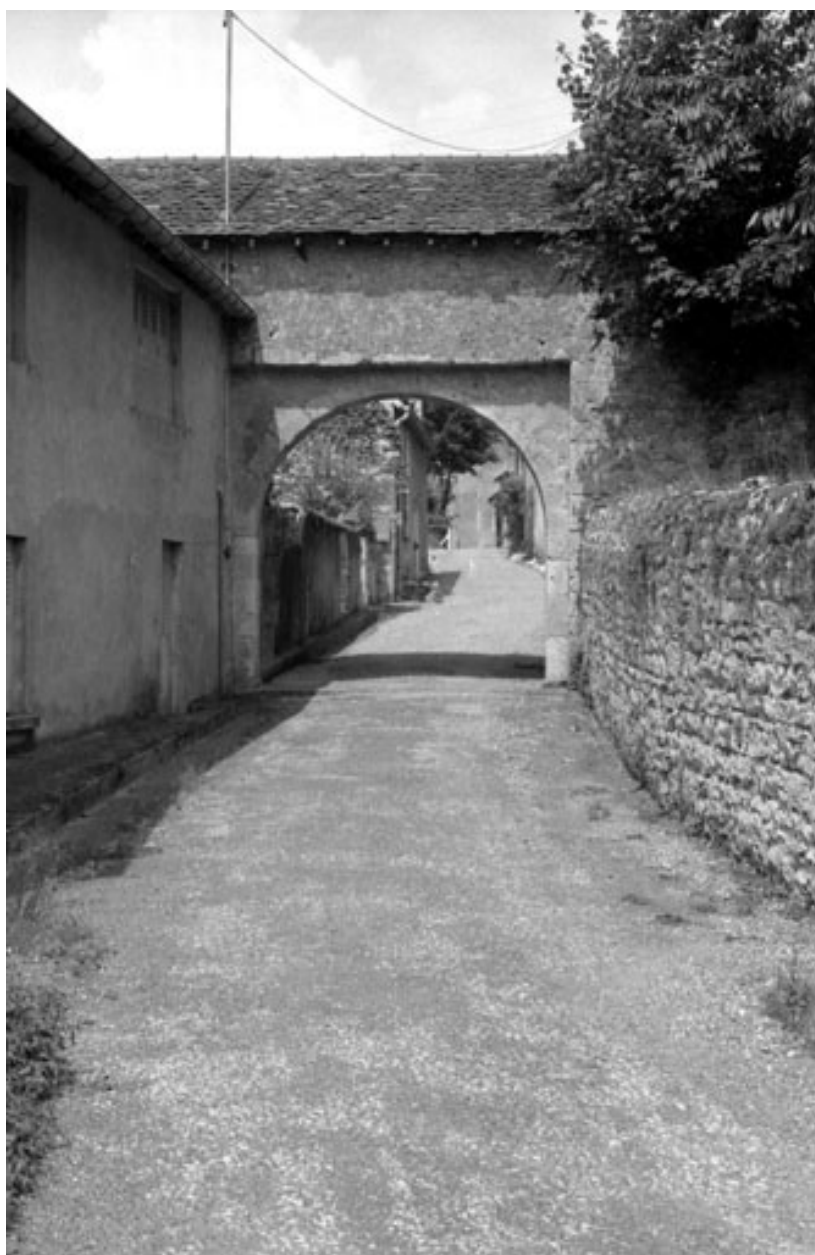
Porte Loigerot : façade extérieure.
